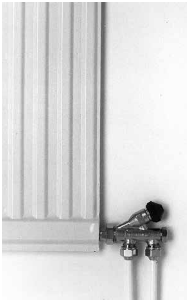
1-strengsventil, sidemonteret
